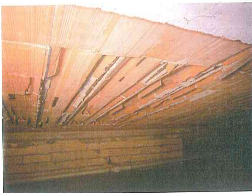
Foto n.8 – Particolare intradosso solaio – Piano fondazioni
