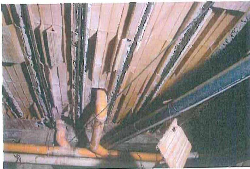
Foto n.7 – Particolare intradosso solaio e sistema fognario acque reflue – Piano fondazioni
